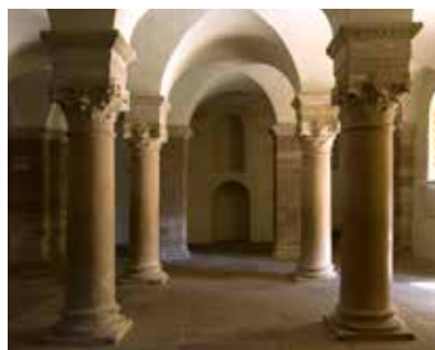
Das Westwerk, Erdgeschoss
